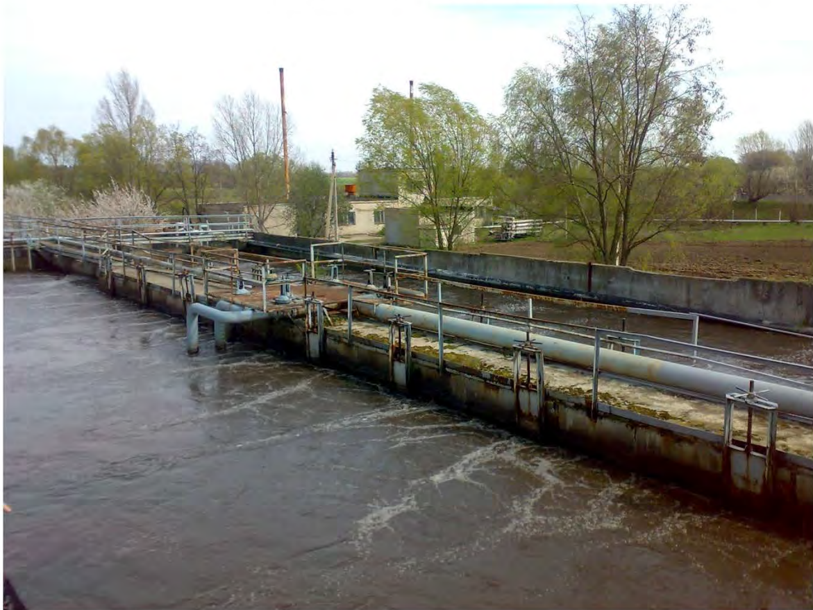
Рис. 9. Очисні споруди м. Боярка
