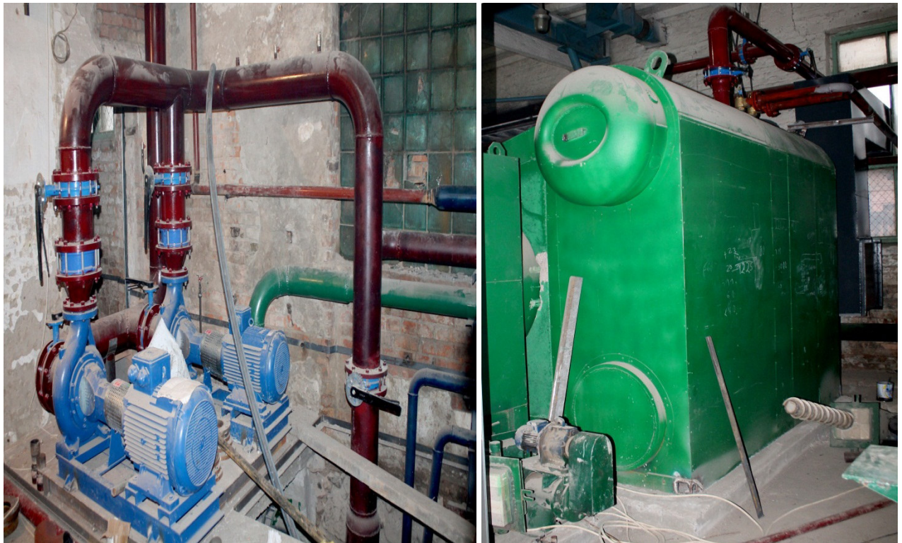
Рис.11.7 Окремі вузли котельні університету на твердому паливі
