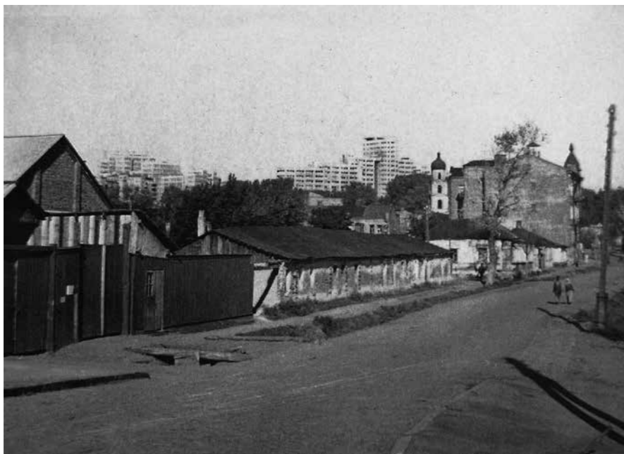
1930-ті рр., Харків. Стара забудова, вул. Іванівська
