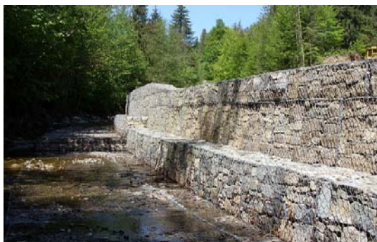
Рис. 2. Габіонне кріплення річки
