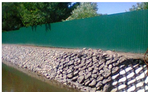
Рис. 4. Заповнення георешітки кам'яним накидом
