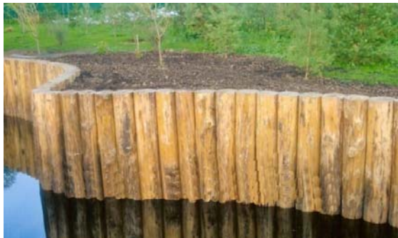
Рис. 3. Кріплення берегів водойми за допомогою дерев'яних паль
