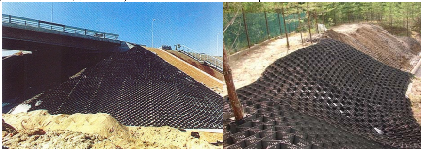
Рисунок. Використання георешітки для захисту зрушення насипу ґрунту
